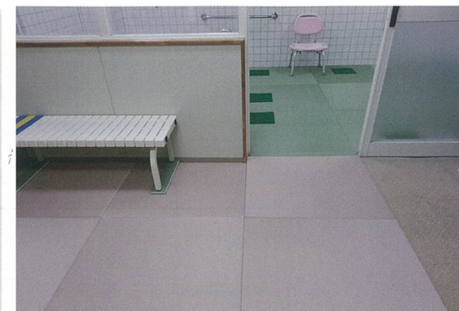
サルビアの家様 養護施設様の浴室にご採用頂き、ソフトな畳で安全性も向上しました。
