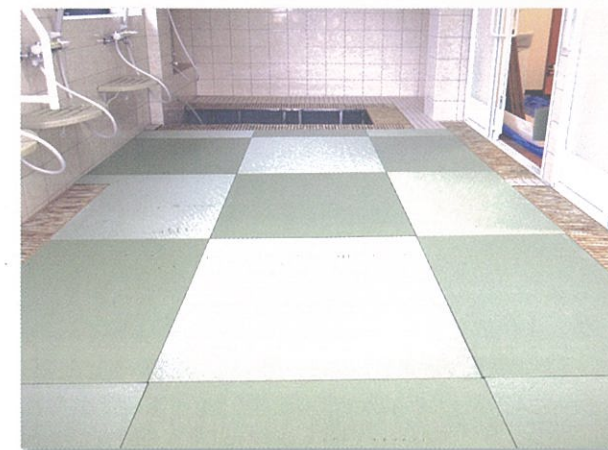
老人ホームあんしん学園様 新築で段差を無くした設計にしています。
