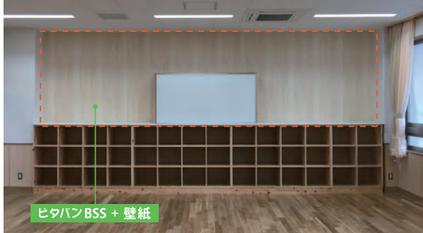
福岡県大川市 桐薫中学校（2020年4月開校） 全教室の背面にピタバンBSSを施工
