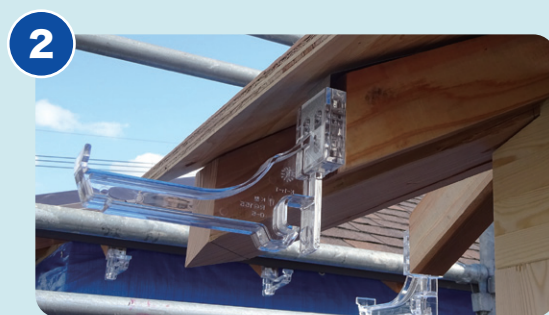
屋根下地施工後。
