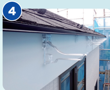
シタジレス・ノキハフダーZ挿入後、金具を本固定。（取付位置も固定されており、位置決め不要）
