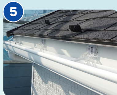
軒どい取付後。
