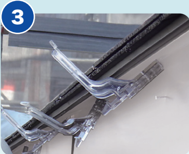
垂木と仮固定した金具の間にシタジレス・ノキハフダーZを挿入。
