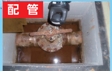
配管スペースの水の除去に！
